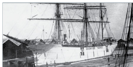
Bergens Mekaniske Verksteder side 12
