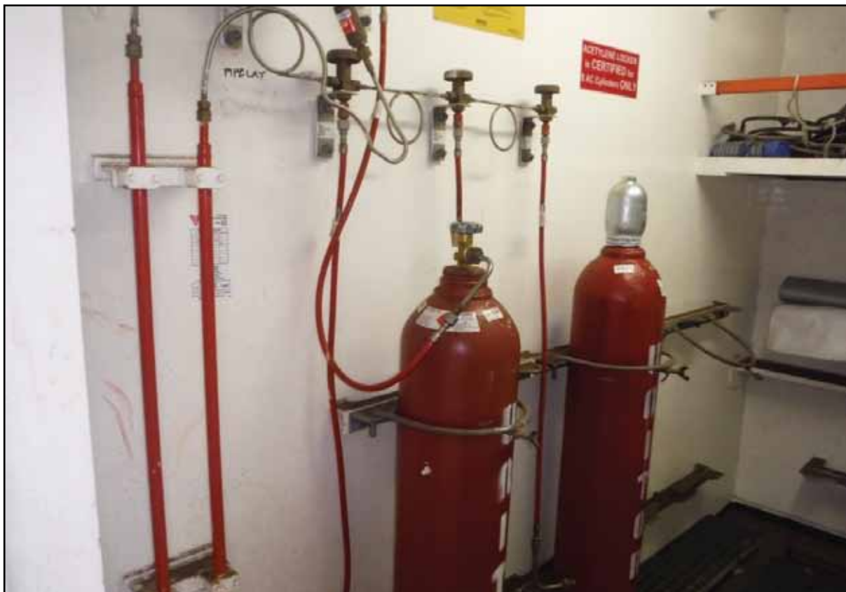
Figur 3: Illustrasjonsbilde fra ett Acetylen lagerrom ombord på ett produksjonsskip.
