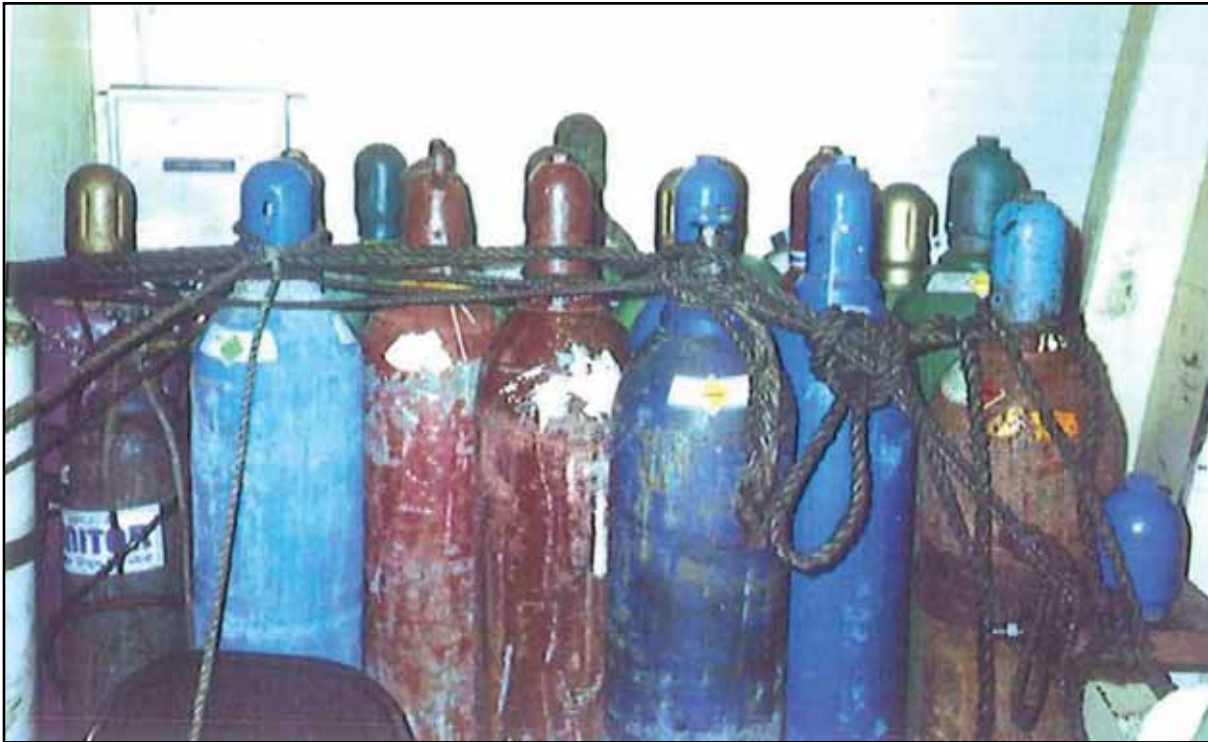
Figur 1: Bilde av stående Acetylen og Oksygen flasker - 40 liter hver. Acetylen er en svært brennbar og eksplosjonsfarlig gass og sammen med oksygen er acetylen enda farligere. Det er derfor sjekket ut hvilken risiko disse gassflaskene representerte for skipet i lys av hvordan brannen utviklet seg.
