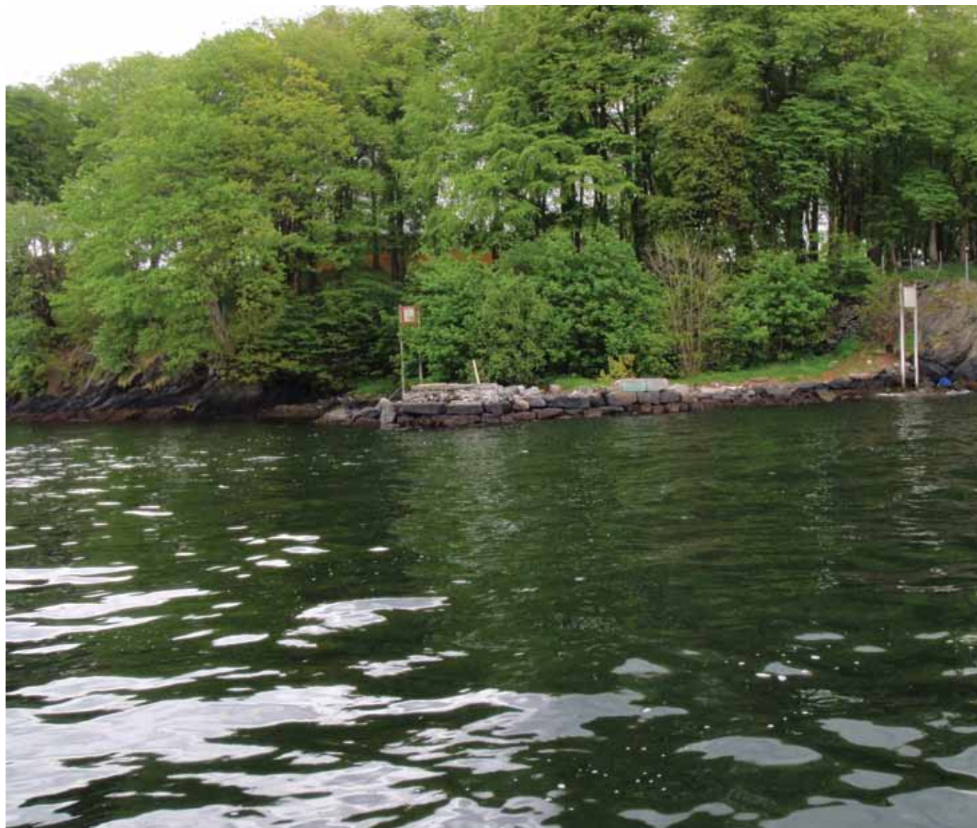
(foto av restene av ballastkaien før 2009): Restene av ballastkaien, foto fra 2008. En del av kaifrontsteinene lå på sjøbunnen rundt kaien. Området var ellers kraftig gjengrodd. (Foto: A. M. Hansen)
