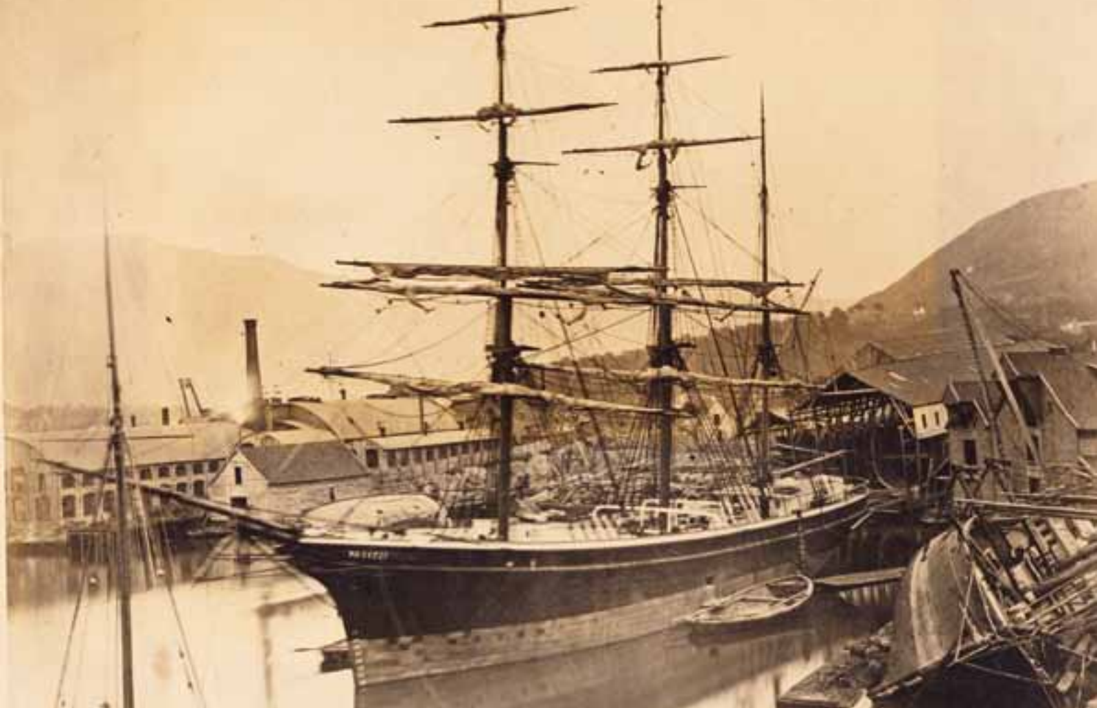
I 1870-årene hadde Bergen en moderne seilskipsflåte. Flere av skipene var bygget i Bergen og det nære byområdet. Ved Graneverftet på Lakse- våg ble det foretatt vedlikeholds- og reparasjonsarbeid. Bildet viser utrustningen av barken Pacific (bygget 1872 for Chr. Ege m.fl.) ved Grane- verftet. Skipet ble solgt til Farsund i 1884 i en tid da bergensrederne ennå kunne få godt betalt for seilskipene. Til høyre et skip under kjølhaling. Foto: BSJ
