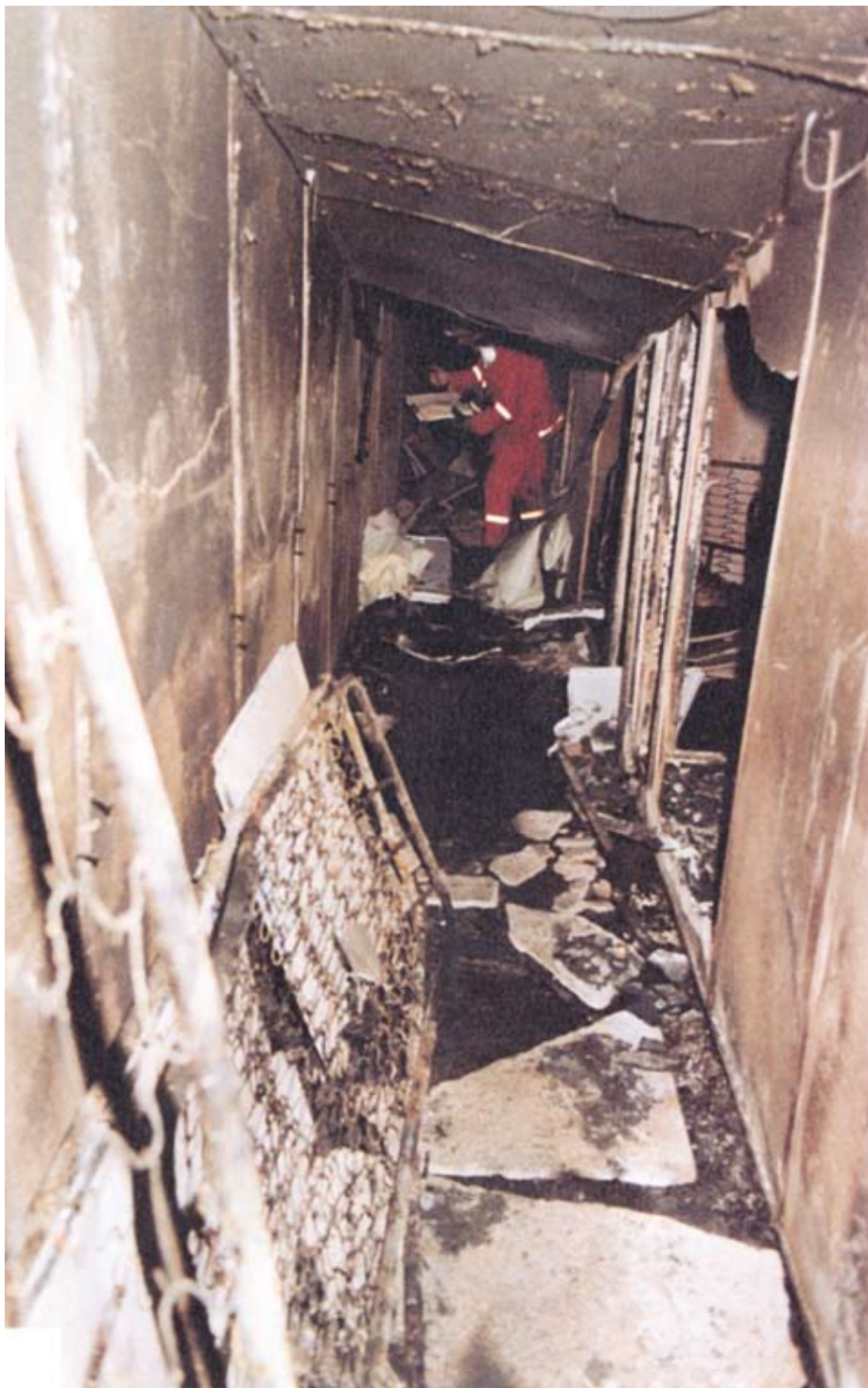
Arnestedet for hydraulikkoljebrannen, samme korridor som det ødelagte h. oljerøret. Foto: Olle Wennstrøm
