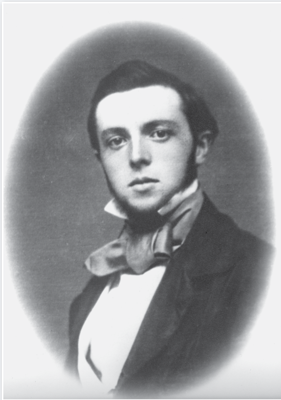
Den unge Annianias Dekke, som ble en av samtidens mest kjente og respekterte skipsbyggere og konstruktører.
