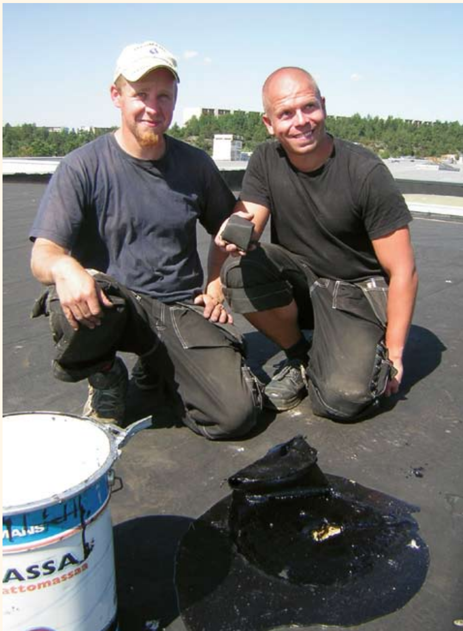
Steinen som gikk gjennom taket til Norgesgruppen utenfor Moss i 2006 og de to entreprenørene som fant steinen da de forsøkte å finne årsaken til en vannlekkasje. Foto: Morten Bilet
