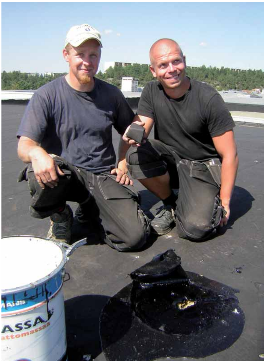
Steinen som gikk gjennom taket til Norgesgruppen utenfor Moss i 2006 og de to entreprenørene som fant steinen da de forsøkte å finne årsaken til en vannlekkasje.
